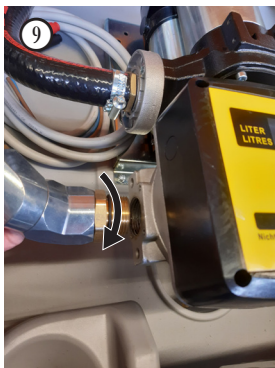
Wiederanbringen des Schlauchs.
